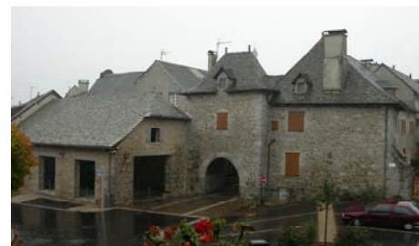
porte Nord vue du 1 er étage
