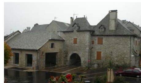
porte Nord vue du 1 er étage
